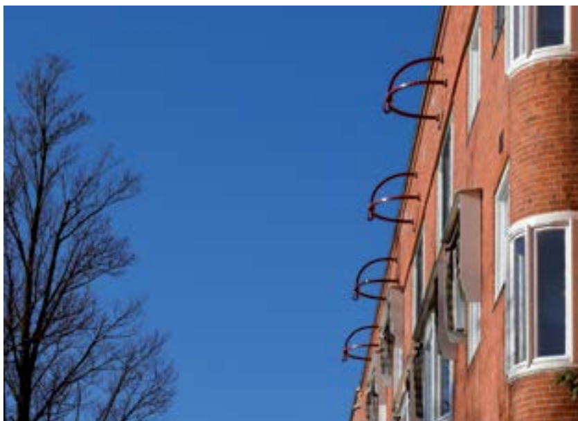
Hijsankers Frans van Mierisstraat
