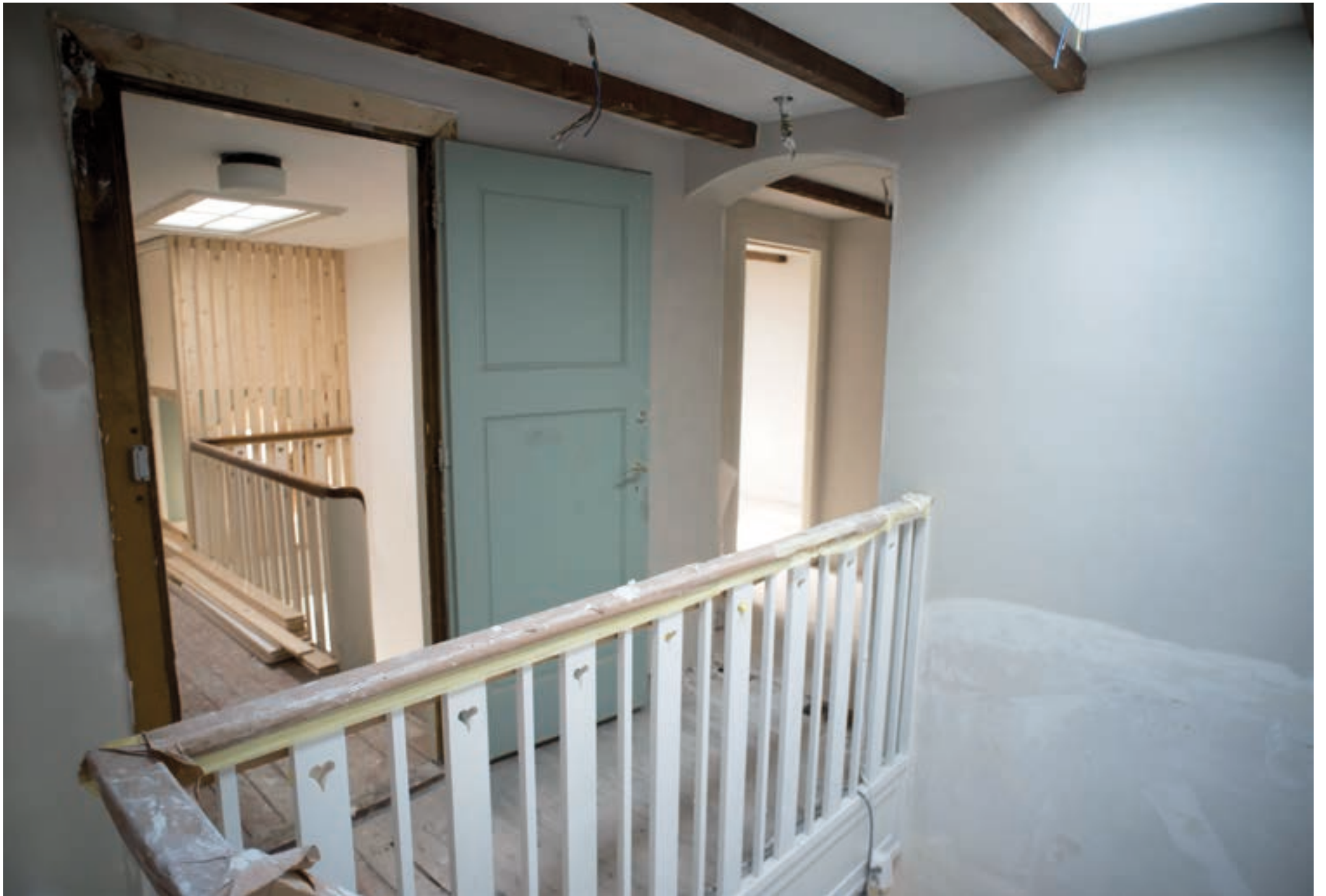
Overloop op de zolderverdieping
