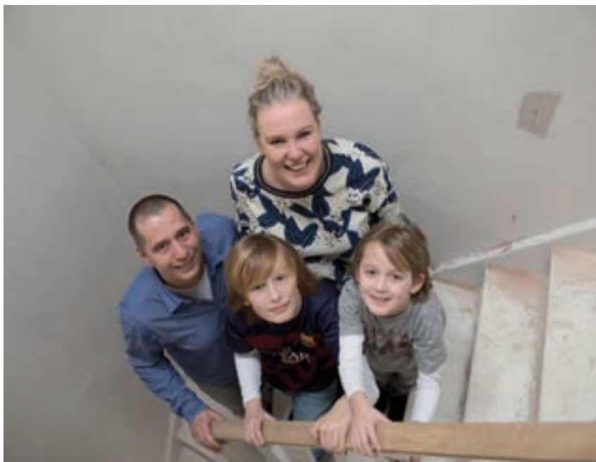
Boven: Badkamer in aanbouw Onder: De familie Franchimont op de nieuwe inpandige trap
